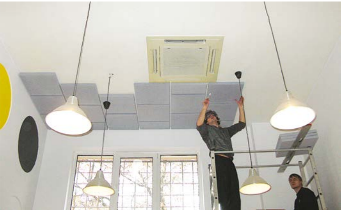
Монтаж на клей потолочных панелей
